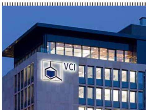
Das Verwaltungsgebäude des Chemieverbandes nach der Sanierung.
